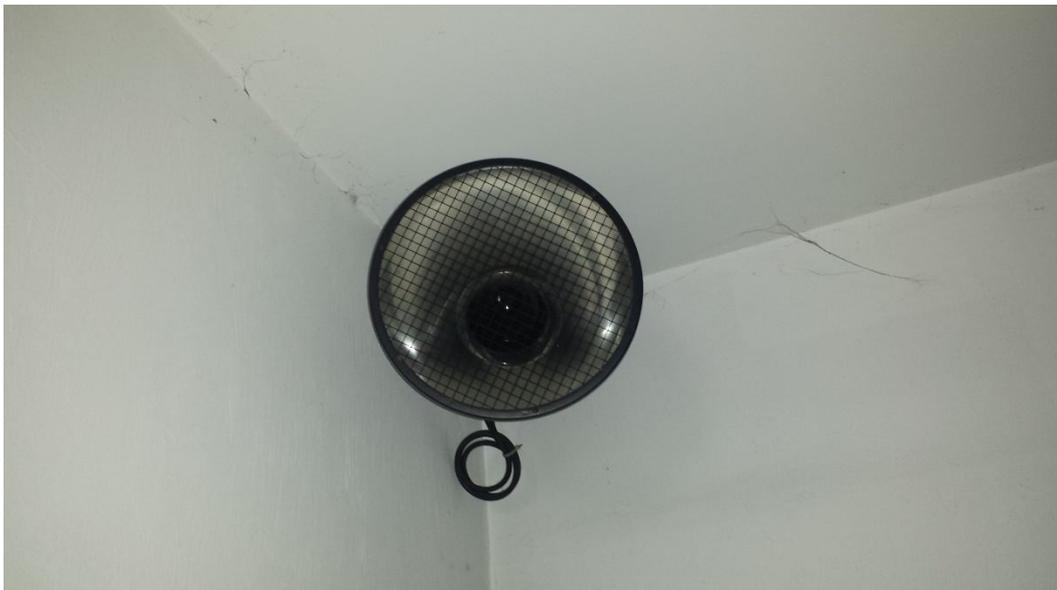
Installation d'un projecteur de cristaux liquides pulsés (Projecteur OPTIKINETICS Modèle SOLAR 250) à 3 mètres de distance minimale du système et à 1 mètre minimum de hauteur.
